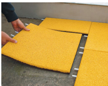
Abb. 1: Verlegung mit T-Fuge
