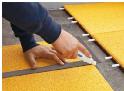
Abb. 6: Zuschneiden mit Teppichmesser
